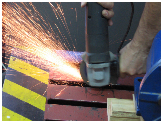
Figura 5.18 - Alargamento dos rasgos na base
